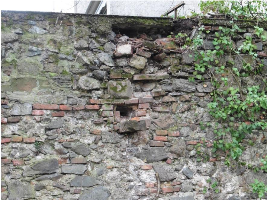
Abb. 2 Schäden durch im Mauerwerk wachsenden Efeu (vor 4 Monaten entfernt)
