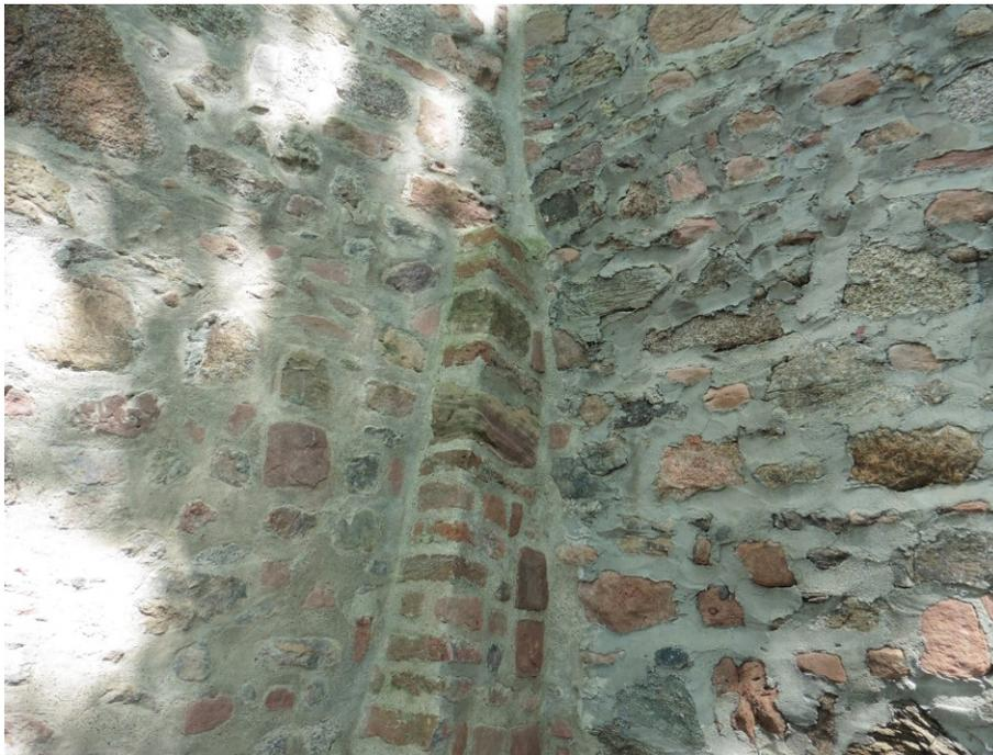
Abb. 6 Unterschiedliche Verfugungen an der Stadtmauer / Zwingerpark
