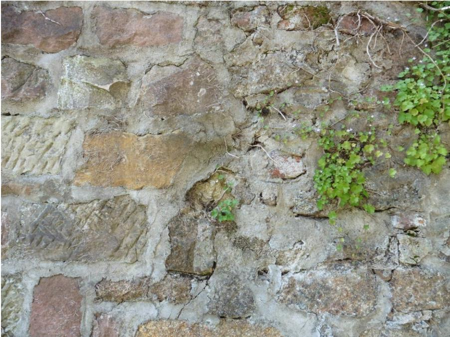
Abb. 1 Verfugung mit Zementmörtel
