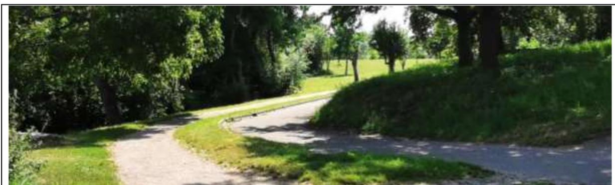
Abbildung 8: Der Radweg im Bereich Waldbach ist baulich beengt, was im Bereich der Verschwenkungen ein Gefahrenpotenzial birgt.
