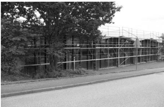
Sanierung der Sporthalle Fessenbach
