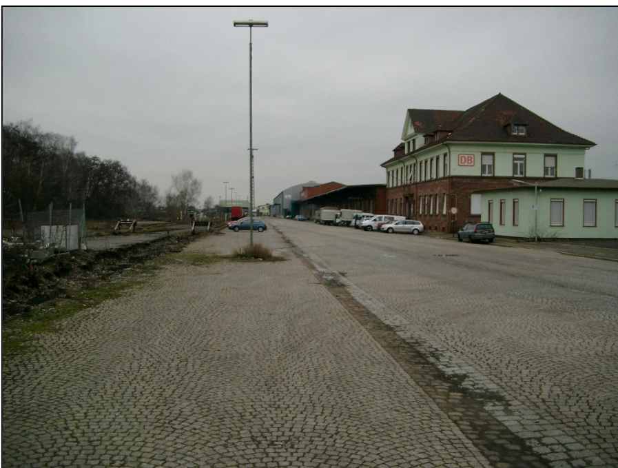
Abbildung 41: Blick auf das Güterbahnhofsareal von Süden
