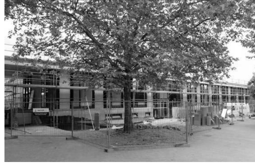
Turnhalle im Bau
