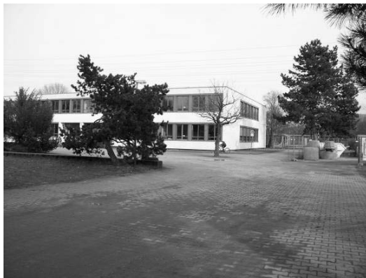
Hauptschulgebäude vor der Sanierung
