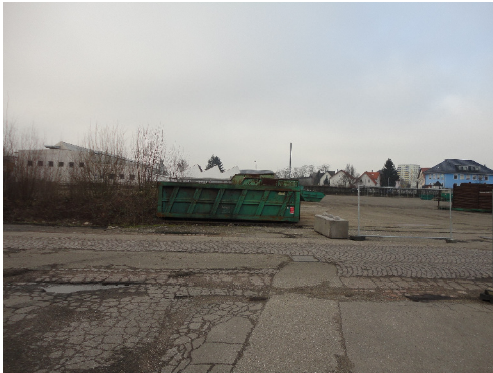
Foto 1 Südlicher Bereich Bebauungsplan „Güterbahnhof-Nord 2“: großflächig versiegelt, geringfügige Spontanvegetation
