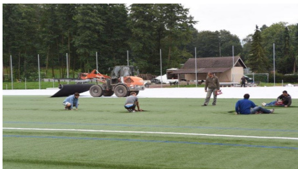
Bau des Kunstrasens in Rammersweier
