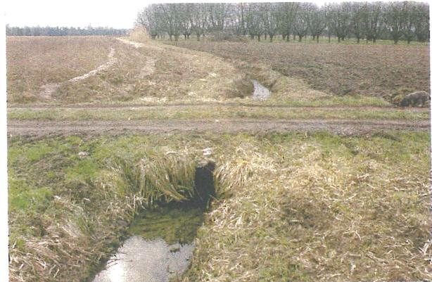
Verdolung Betonrohr; V-förmiges Regelprofil, Aufnahme Februar 2003 (km 1+160 abwärts)
