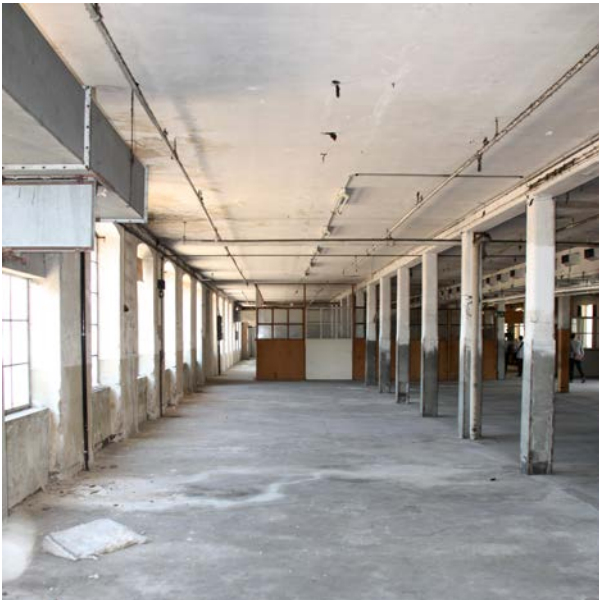
Industrieboden im Webereihochbau EG und 1. Stock
