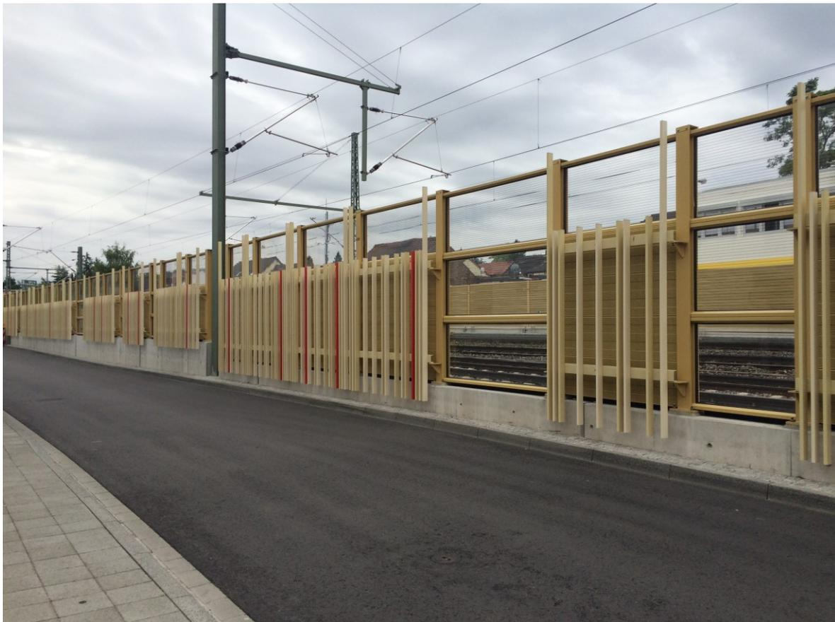
Abbildung 3: In Karlsruhe im Rahmen der Lärmsanierung erstellte Lärmschutzwand
