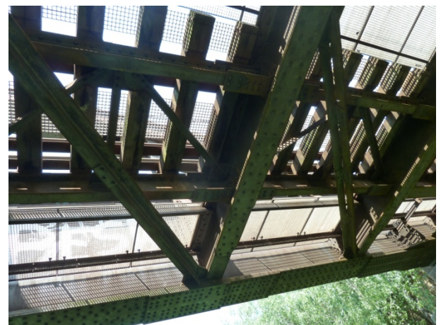
Abbildung 4: Sicht von unten auf die Fahrbahn
