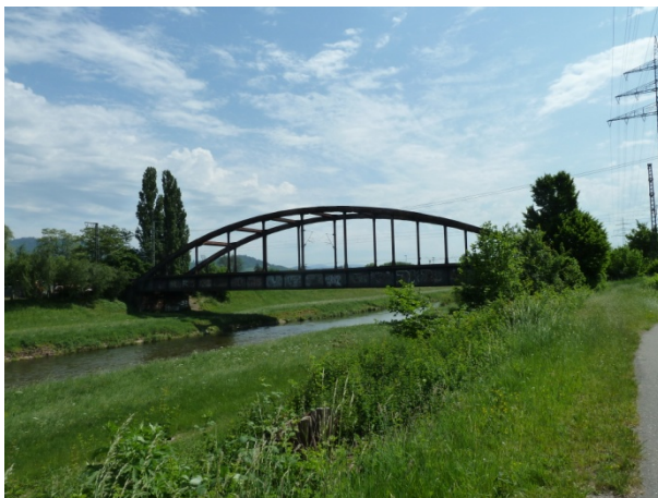
Abbildung 1: Seitliche Ansicht der Brücke (aus nordwestlicher Richtung)
