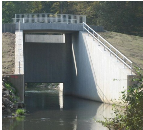
Exemplarisches Bild eines Kombinationsbauwerkes (Ansicht von der Luftseite)
