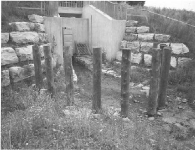
Abb. 1: Beispiel für Palisadenrechen
