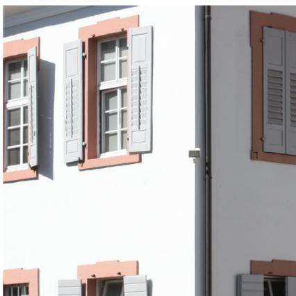
**ABB. 070** Historische Fensterteilung und Klapppläden an einem sanierten Altbau
