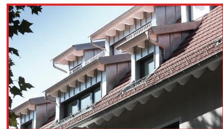
ABB. 051 **⊗ NEGATIVBEISPIEL** Wuchtige Ausbildung der Gauben, vor allem durch den großen Gaubendachüberstand und die massiven Sparrenköpfe. Verkleidung der Gaubenwange mit Zinkblech
