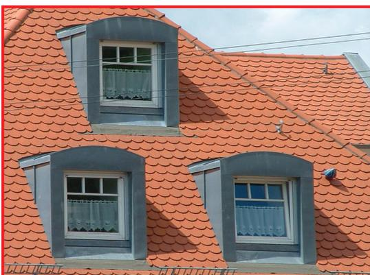
ABB. 057 ✘ NEGATIVBEISPIEL Durch den Einsatz von massiven Dämmungen sehen heutzutage viele Gauben wuchtig und überdimensioniert aus
