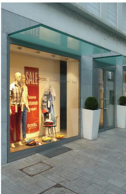
ABB. 026 Eingespannte Glasscheibe dient als filigranes Vordach
