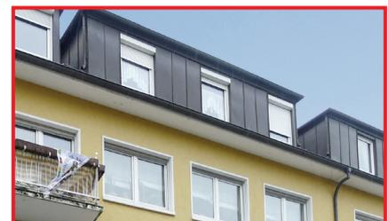
ABB. 053 **⊗ NEGATIVBEISPIEL** Durchlaufende Gaubenbänder führen zur optischen Auflösung des Daches
