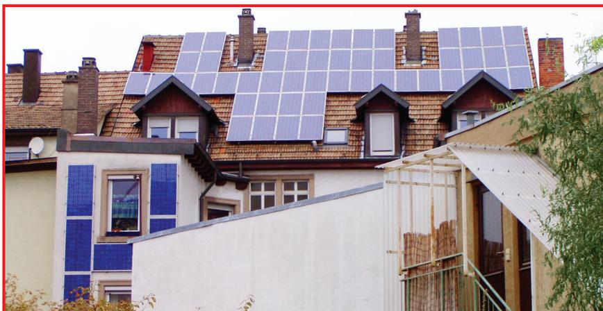
ABB. 059 ❌ NEGATIVBEISPIEL Wildwuchs von Solarmodulen
