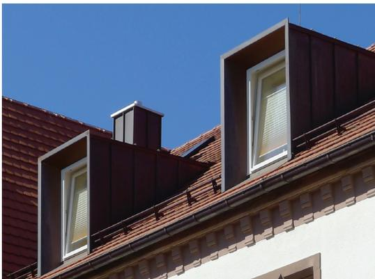
ABB. 056 Moderne Kastengauben mit schlankem Wandaufbau und matter, dunkel beschichteter Metallverkleidung
