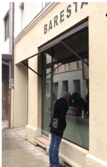
ABB. 027 Fallarmmarkisen lassen sich aufgrund ihres geringen Platzbedarfs gut in Fensternischen integrieren
