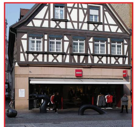
ABB. 068 ✘ NEGATIVBEISPIEL Aushöhlung der Erdgeschosszone durch Schaufensterband
