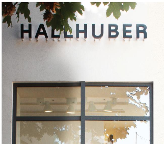
ABB. 103 Werbeanlage nimmt Fensterachsen auf
