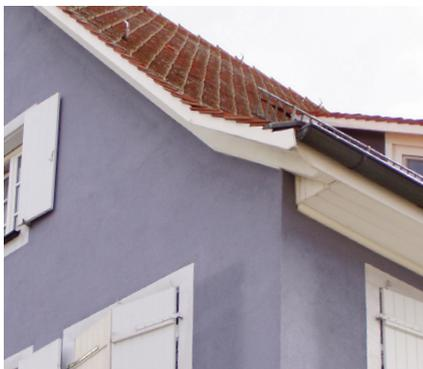
ABB. 047 Ortstypischer Abschluss des Ortgangs mit einer Zahnleiste
