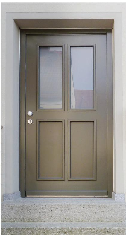
ABB. 078 Eine gestemmte Holztür in moderner Ausführung und Farbgebung
