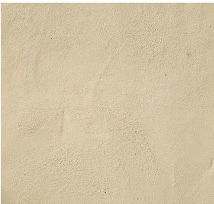
ABB. 013 Freihändig verriebener Glattputz
