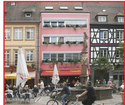
ABB. 011 **⊗** NEGATIVBEISPIEL Störung der ortstypischen Fassadengliederung durch Bandfassade.
