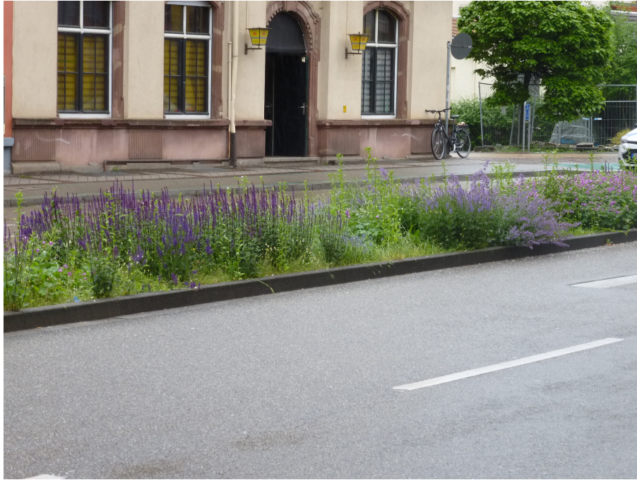
Staudenpflanzung als Verkehrsteiler. 'Blaues Band' als Trennelement zwischen verschiedenen Fahrrichtungen des Autoverkehrs, Beispiel Hauptstraße (11)
