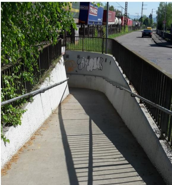
Das bestehende Bauwerk hat eine lichte Weite von ca. 1,50 m und eine lichte Höhe von ca. 1,90 m. Die Rampen weisen eine Neigung von ca. 12% aus. Auf der Nordseite befinden sich flache Treppenstufen.
