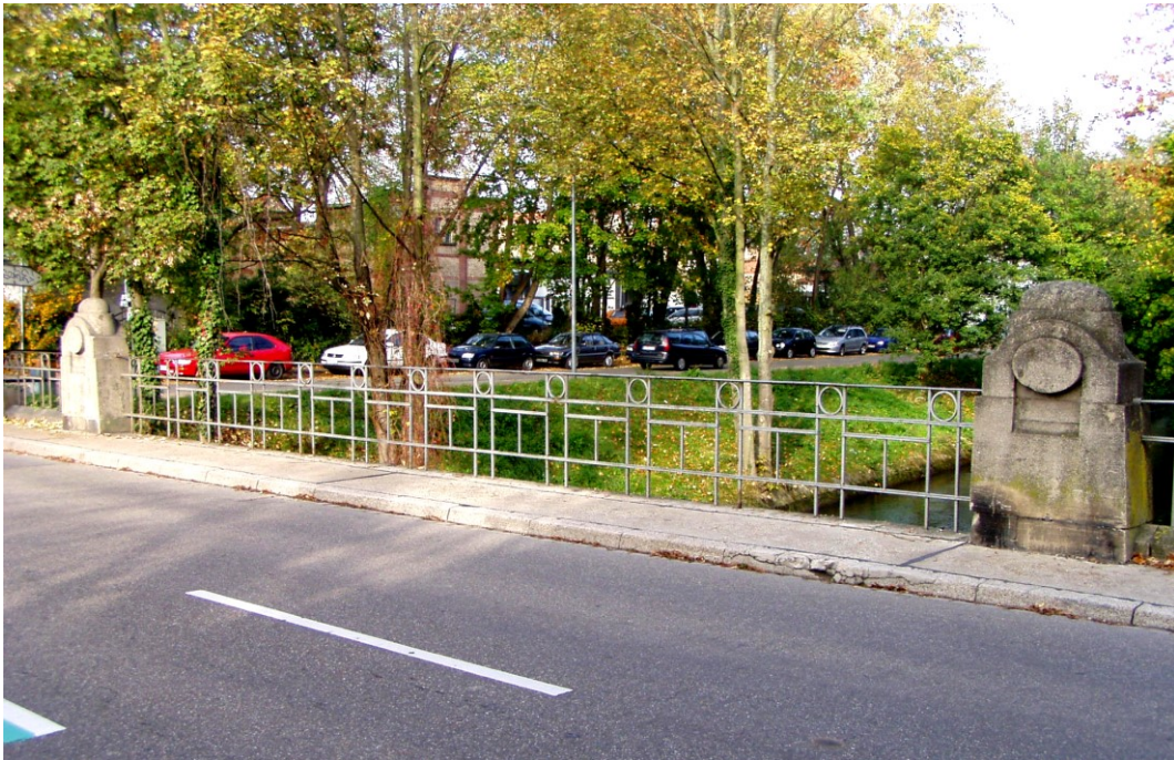
Abb. 2 Nördliches Geländer der Mühlbachbrücke
