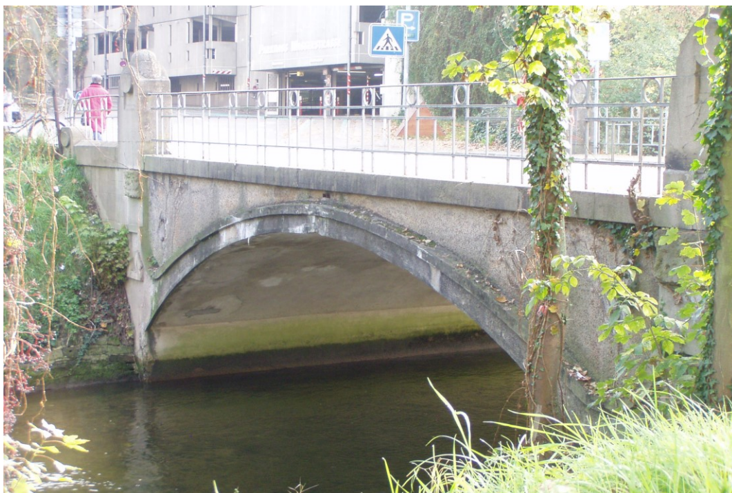
Abb. 1 Nordseite der Mühlbachbrücke
