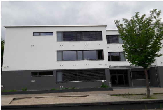
Waldbachschule nach der Sanierung
