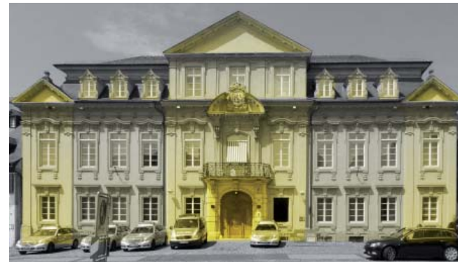
Inszenierung Königshof; vertikale Fassadengliederung mit Streiflicht, Illumination Eingangsportal und Giebel
