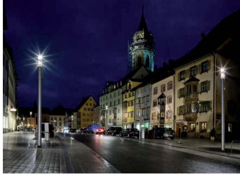
Referenzprojekt mit Umrüstung der Lichtfarbe: Hochbrücktorstraße, Rottweil
