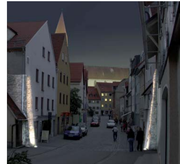
Referenzprojekt Kaufbeuren: Herausarbeitung eines Durchgangs durch die Stadtmauer mit angestrahltm Stadtmauerkanten
