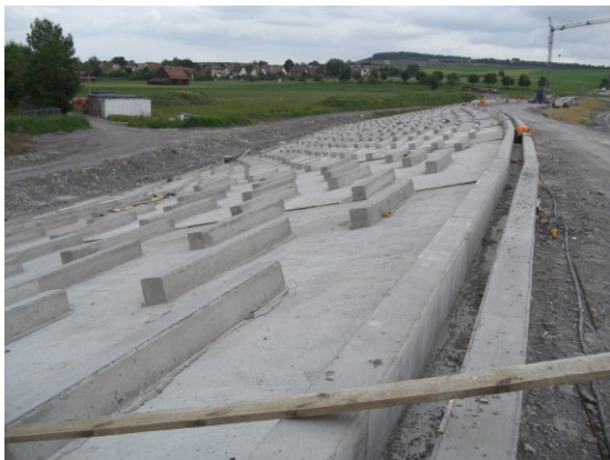
Bild 1: Beispiel HWEA während Bauphase
