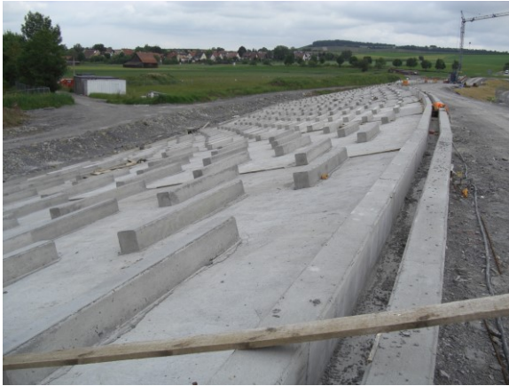
Bild 1 - Beispiel Dammscharte während Bauphase
