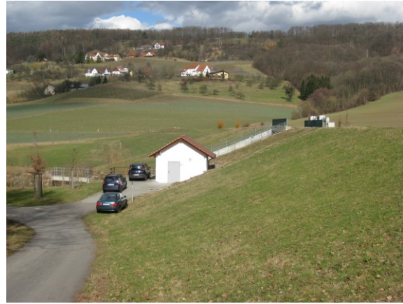
Bild 2 - Beispiel Dammscharte nach Begrünung
