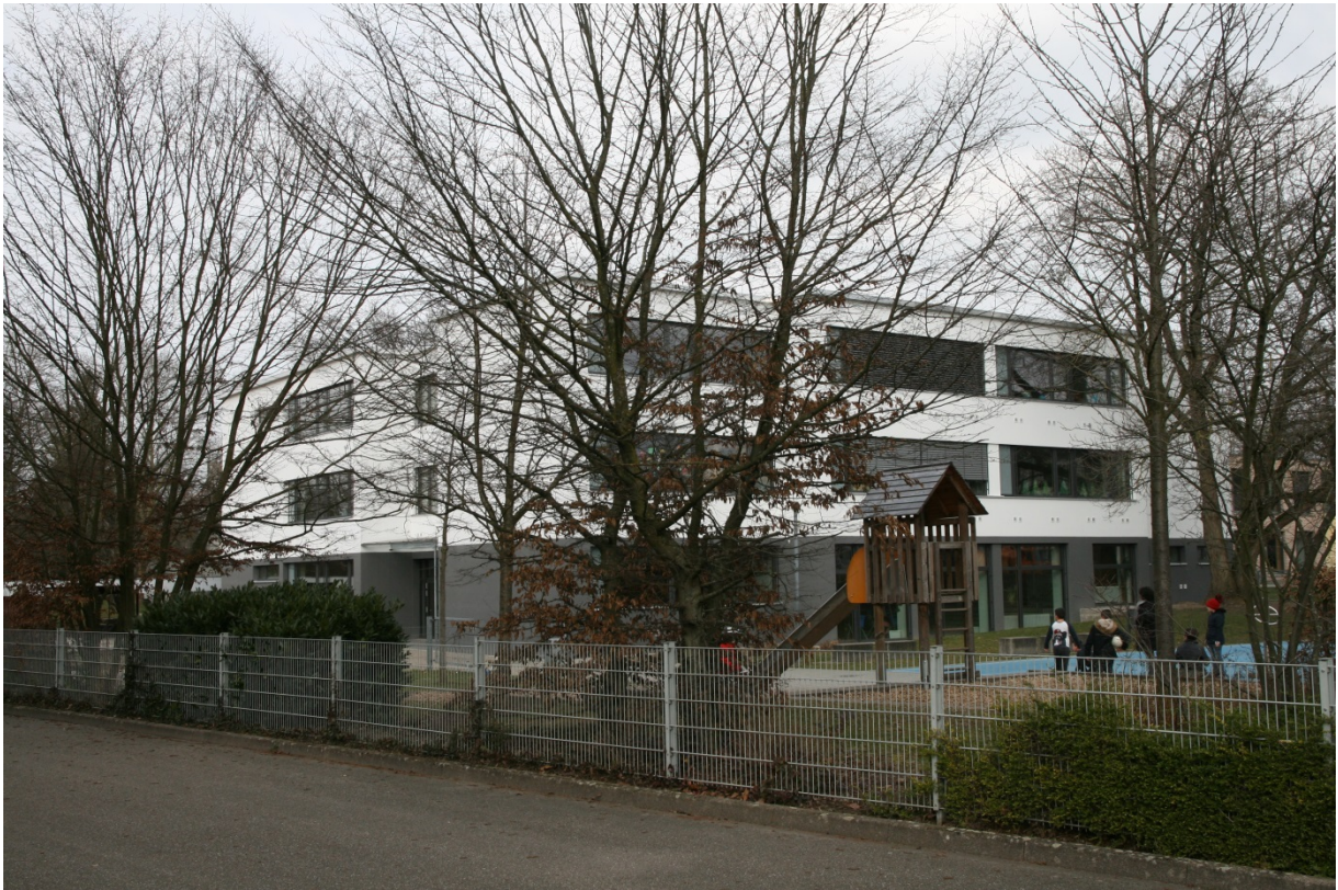
Abb. 1 energ. Modellsanierung Waldbachschule
