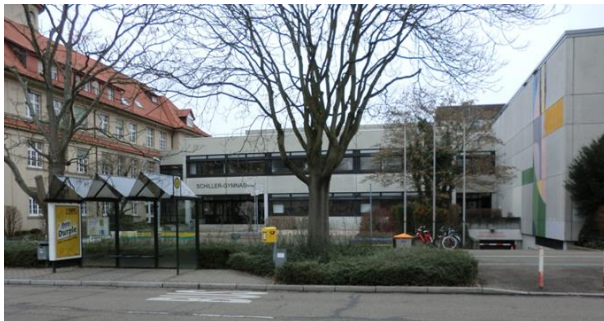
Umbau und energetische Sanierung Schiller-gymnasium
