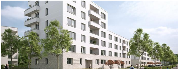
Neubau von Mietwohnungen im Baugebiet Seidenfaden
