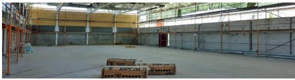
Sanierung der Halle Weier
