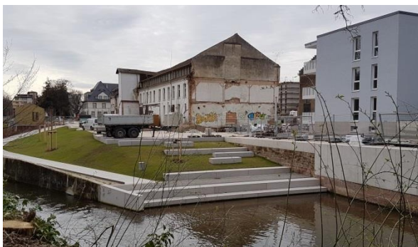
Neubaumaßnahmen im Mühlbachareal
