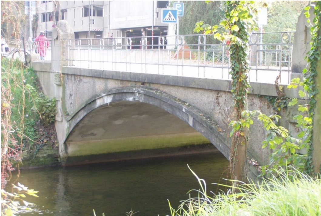
Abb. 1 Nordseite der Mühlbachbrücke
