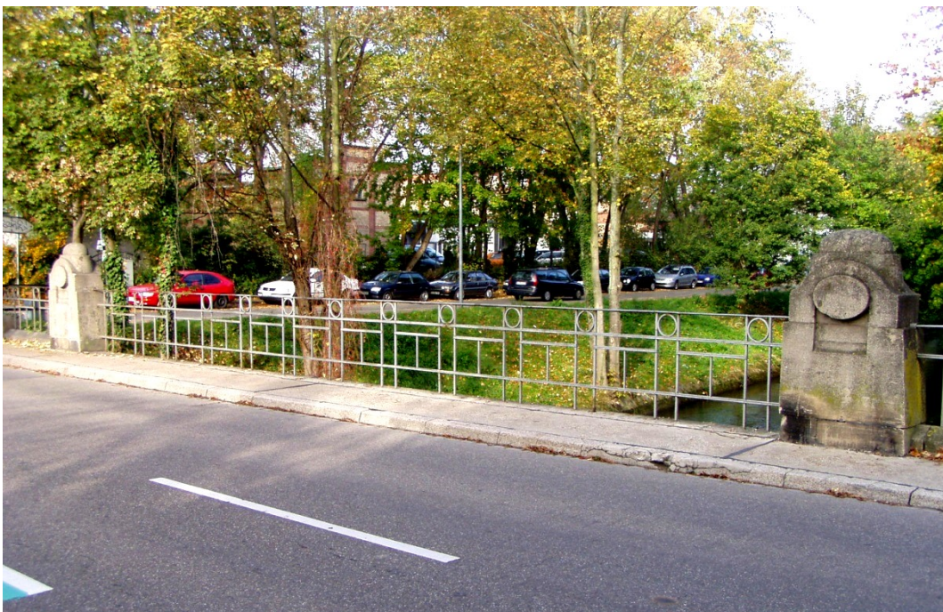
Abb. 2 Nördliches Geländer der Mühlbachbrücke
