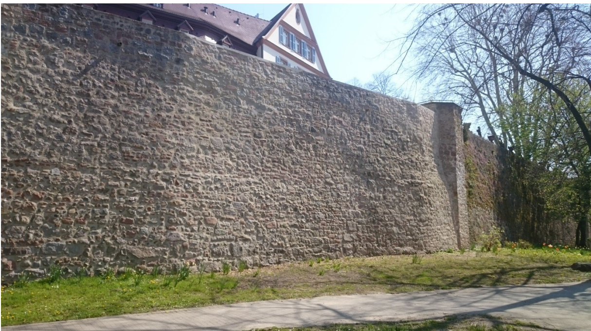
Abb. 5 Abschnitt IX mit der nördlichen Kanzel des Vinzentiusgartens nach der Sanierung
