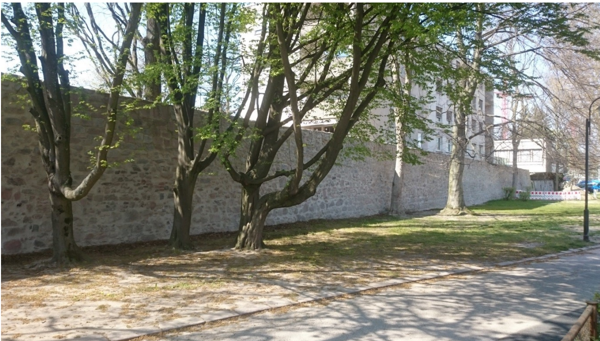
Abb. 3 Abschnitt I nach der Sanierung
