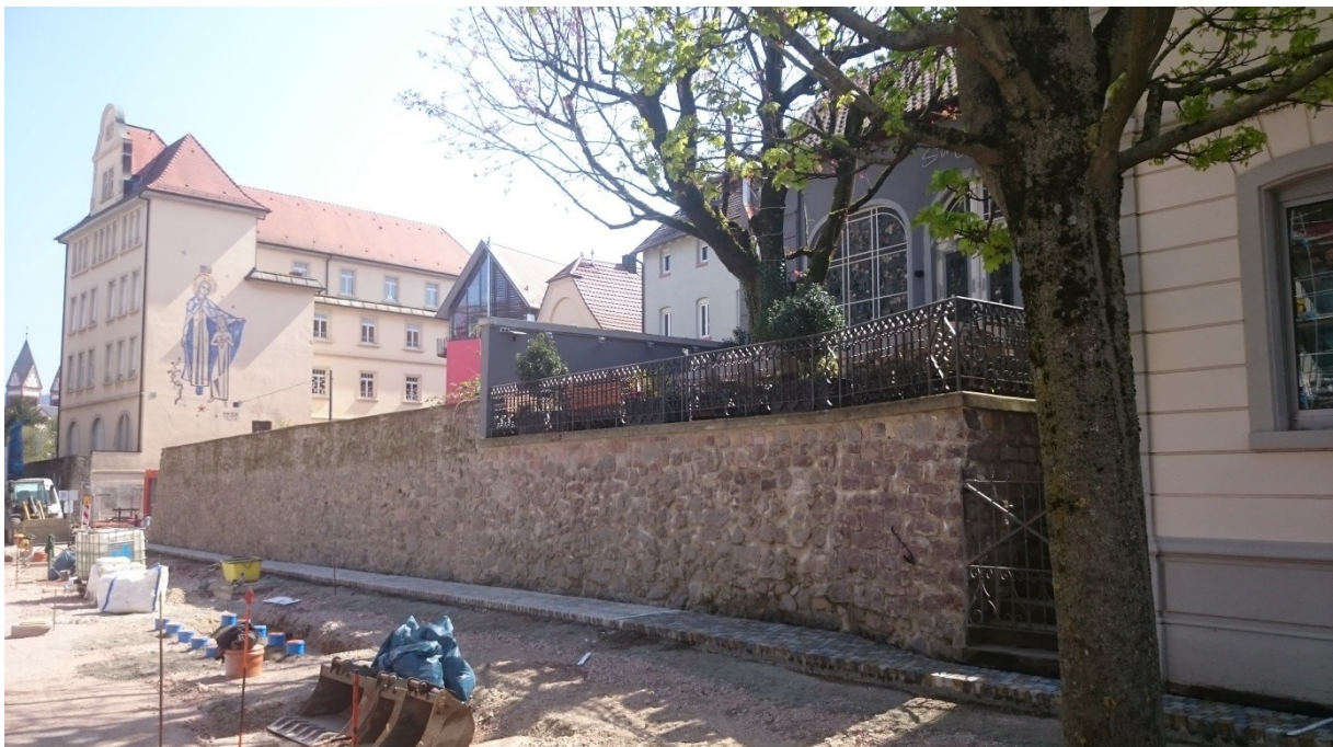
Abb. 4 Abschnitt IV nach der Sanierung
