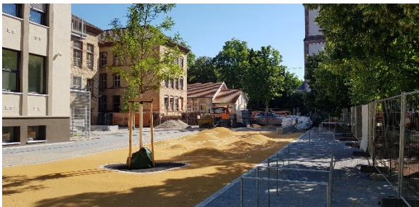
Umbau und Sanierung Georg-Monsch-Schule
