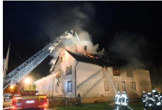
Dezember 2019: Gebäudebrand Ichenheim / Hauptstraße
