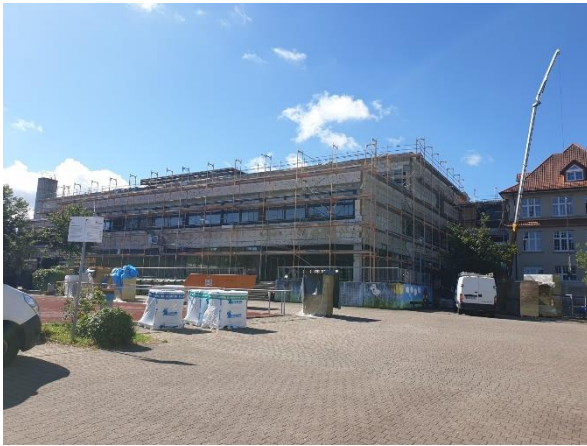
Umbau und energetische Sanierung Schillergymnasium
