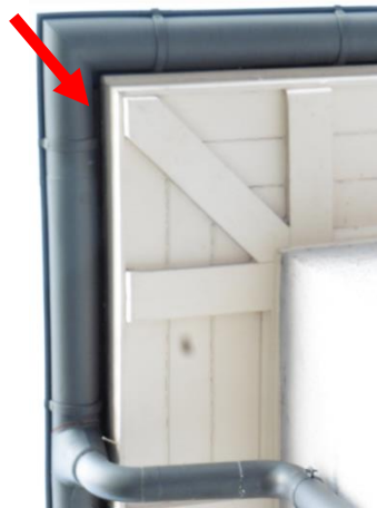
Abb. 6 - Potenzielles Quartier am Wohngebäude entlang der Von-Rienecker-Straße (linkes Bild). Potenzielles Tagesquartier am Wohngebäude an der Okenstraße (rechtes Bild) (jeweils gekennzeichnet durch einen roten Pfeil)
