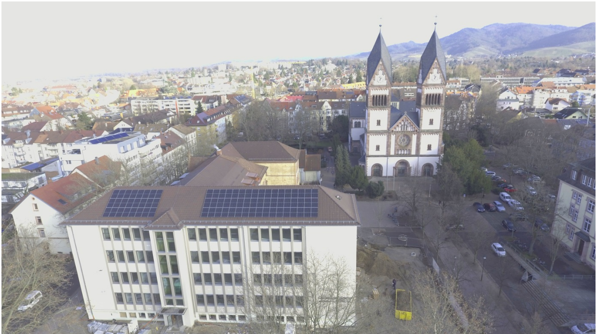
Abb. 1 energ. Sanierung mit PV-Anlage der Georg-Monsch-Schule
