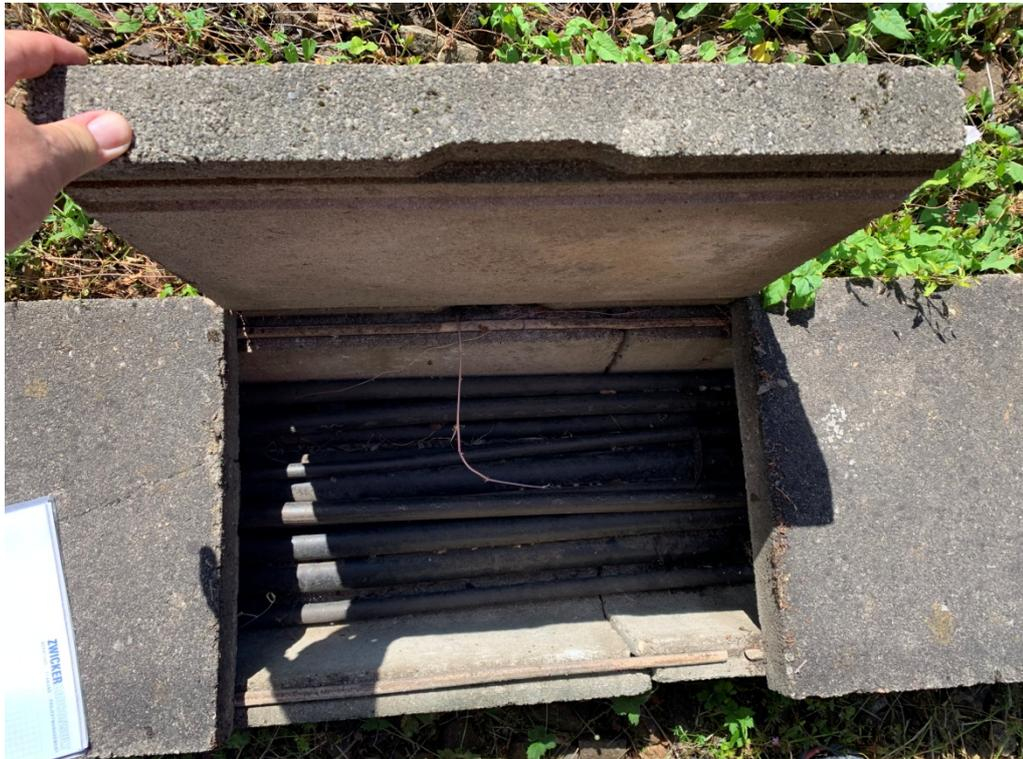
**Bild 8: Kabelkanal Nordseite (r.d.B.)**
