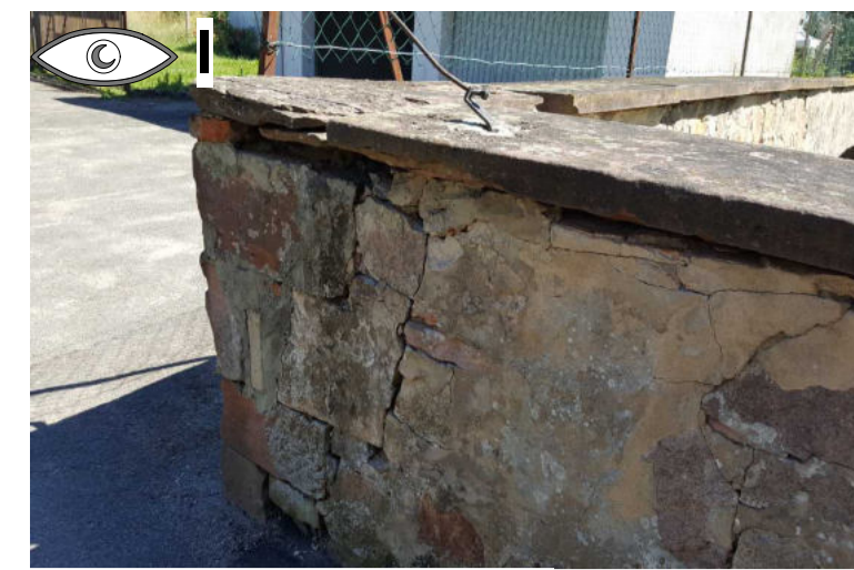
Sukzessive Sanierung der Mauer
