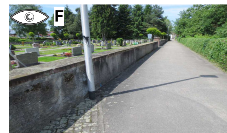
Sanierung der Mauer
