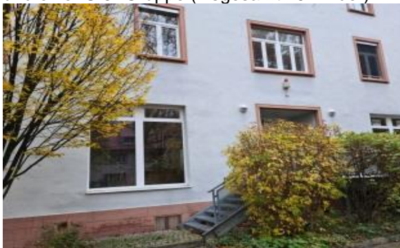
Baustelle der neuen Kita im Afög – Gebäude in der Prinz-Eugen-Straße 4, gegenüber dem SFZ Buntes Haus.
