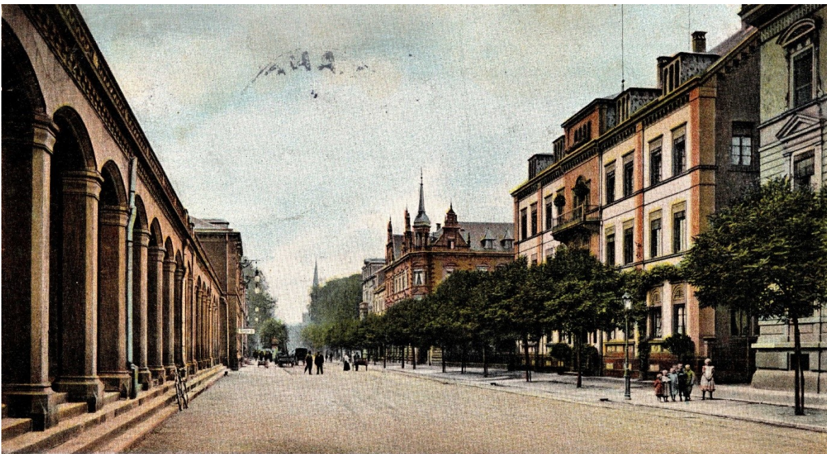
Abb. 4 - Bahnhof und Bahnhofsvorplatz um 1900, Links die offenen Arkaden des historischen Kernbaus vor dem Umbau um 1910, rechts das ehemalige Bahnhofshotel und die Badenia
