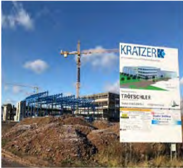
Fa. Kratzer Neubau Produktionshalle Waltersweier (Foto: Kratzer)
