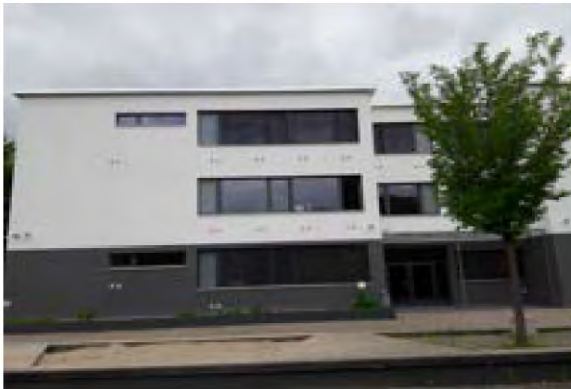
Waldbachschule nach der Sanierung
