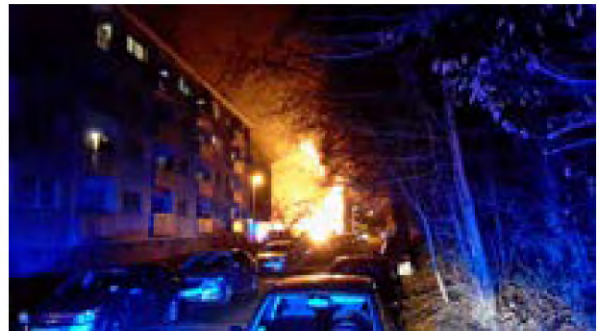
Brand einer Fassade mit Wärmedämmverbundsystem. Bild: Wolfgang Schreiber.
