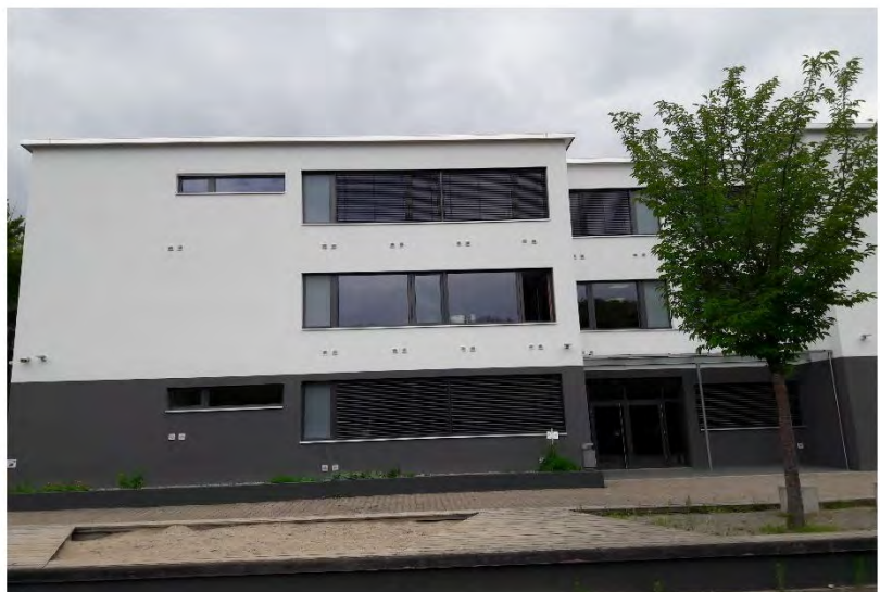
Waldbachschule nach der Sanierung
