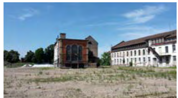
Gelände der ehemaligen Spinnerei Offenburg mit Kesselhaus und Webereihochbau
