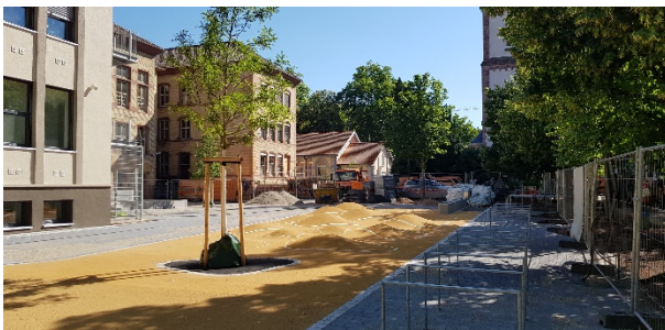
Umbau und Sanierung Georg-Monsch-Schule
