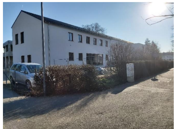
Ansicht Nordostseite Bauteil A – Fertigstellung
