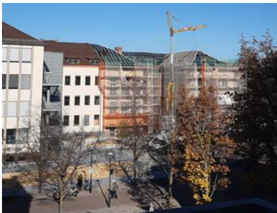
Ansicht Osten – Fassadenarbeiten 2. BA
