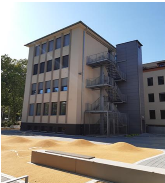
Ansicht Osten – Fertigstellung 1. BA
