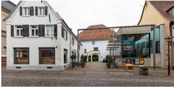
Gesamtensemble mit Zugangsbereich - Lange Strasse
