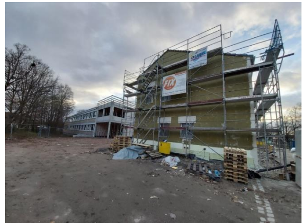
Ansicht Nordostseite Bauteil A - Rohbauarbeiten
