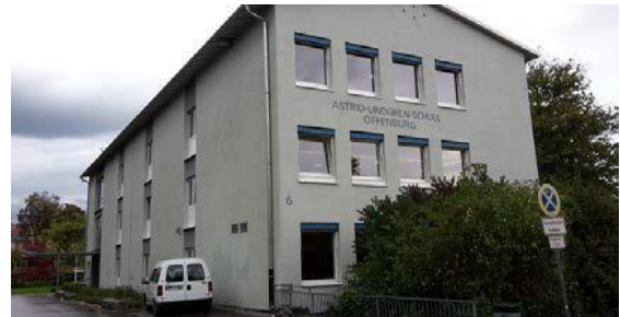
Nördliches Hauptgebäude Bestand
