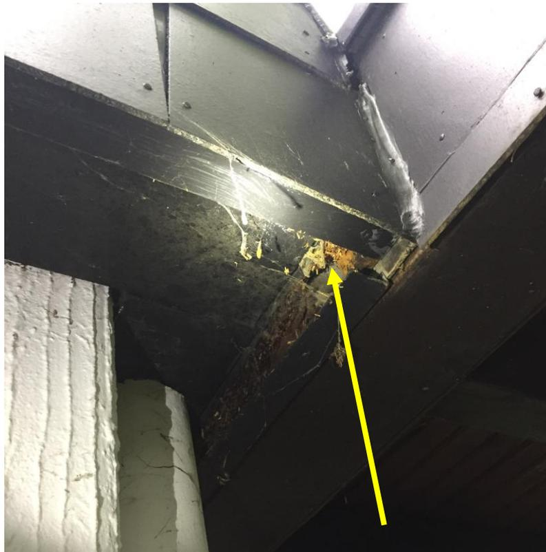
**Abbildung 4.2-3.** Lose Dachverkleidung an der südöstlichen Ecke des Hauses (Aufnahme am 06.05.2021).
