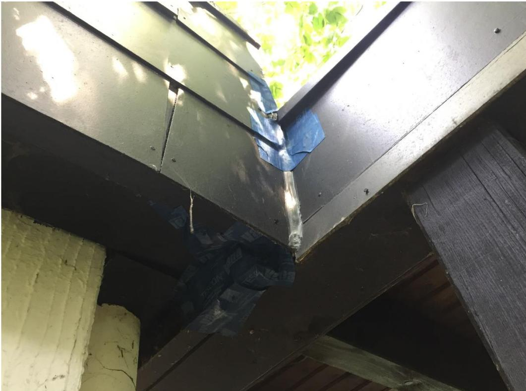
**Abbildung 4.2-7.** Verschluss der potenziellen Einflugöffnungen an der südöstlichen Hausecke (Aufnahme am 22.07.2021).
