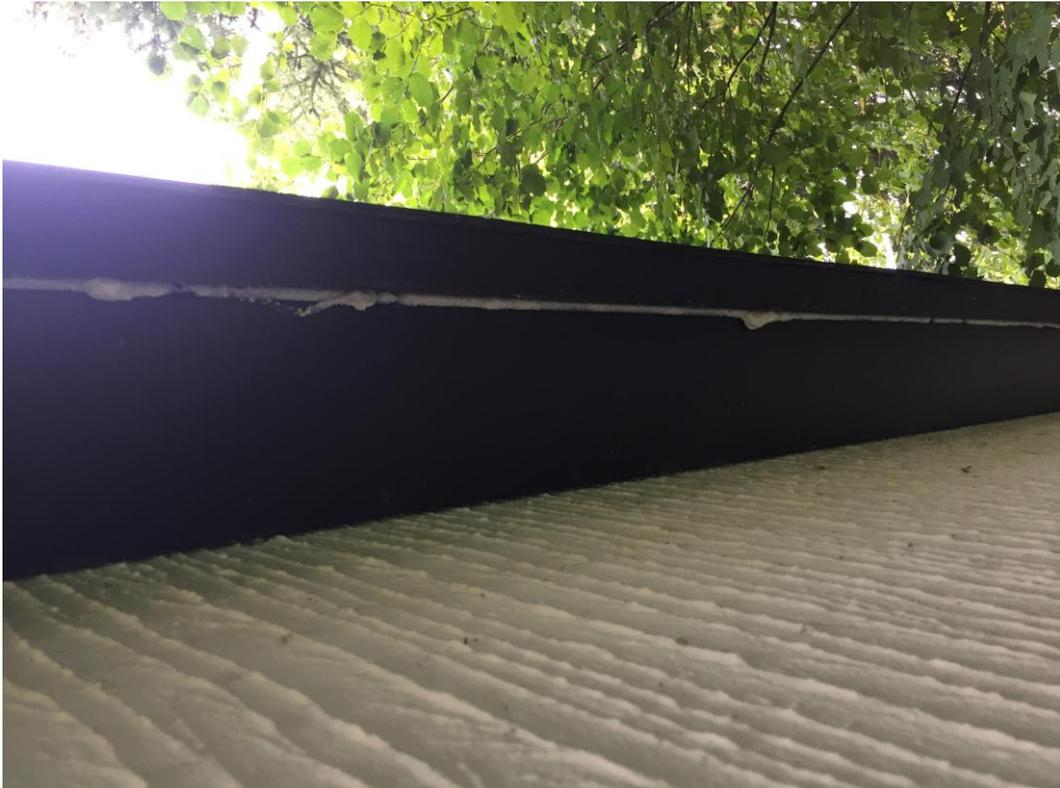
**Abbildung 4.2-8.** Verschluss eines Spalts am Dachkasten mit Bauschaum (Aufnahme am 22.07.2021).
