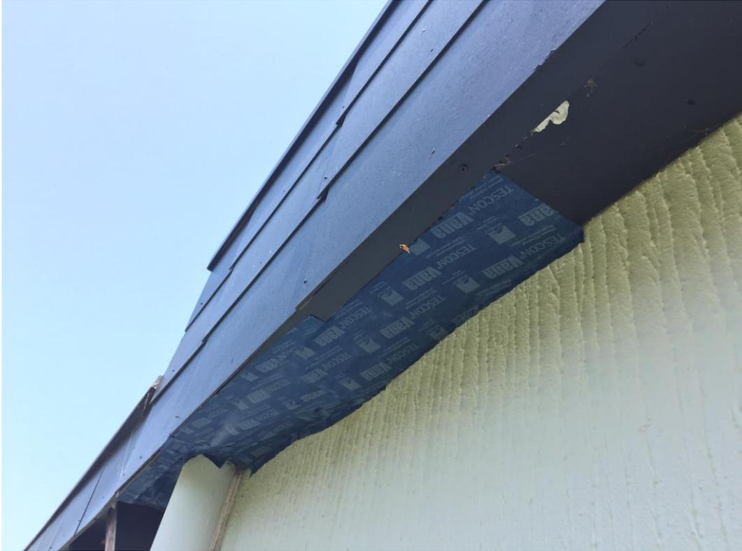
**Abbildung 4.2-6.** Verschluss einer potenziellen Einflugöffnung in den Dachkasten mit witterungsbeständigem Klebeband (Aufnahme am 22.07.2021).
