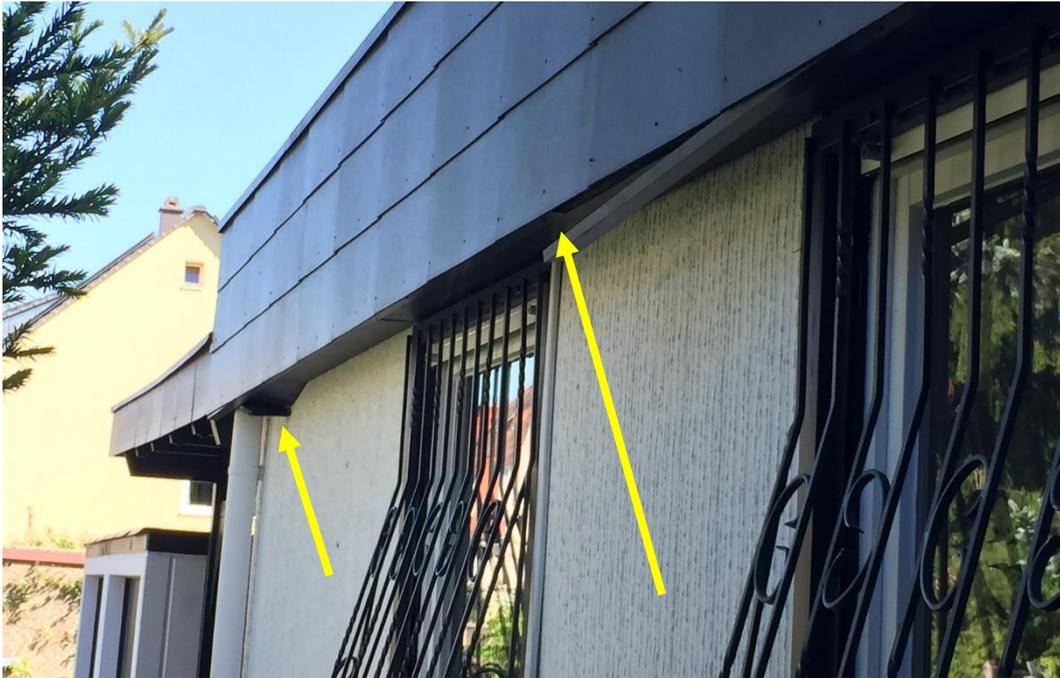
**Abbildung 4.2-2.** Lose Latten an der Dachverkleidung der Frontseite des Hauses (Aufnahme am 01.06.2021).
