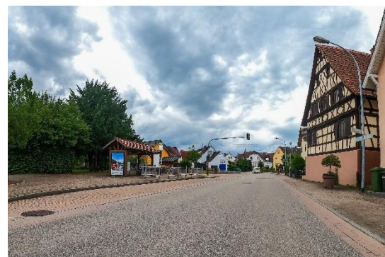
Abbildung 81: umgestaltete Ortsdurchfahrt in Waltersweier
