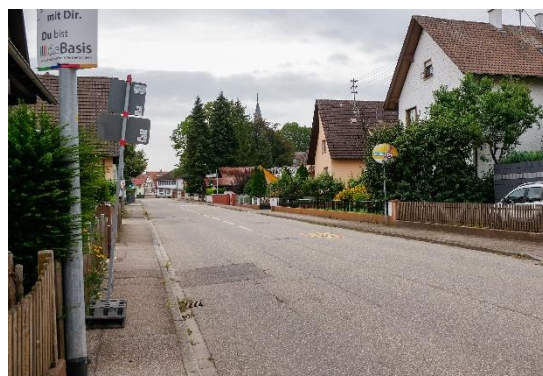
Abbildung 18: Engstelle an Ortsdurchfahrt
