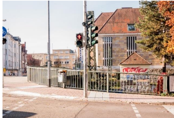
Abbildung 24: Lichtsignalanlage mit Doppelquerung und akustischem Signalgeber
