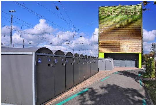
Abbildung 41: Fahrradabstellplätze mit Überdachung
