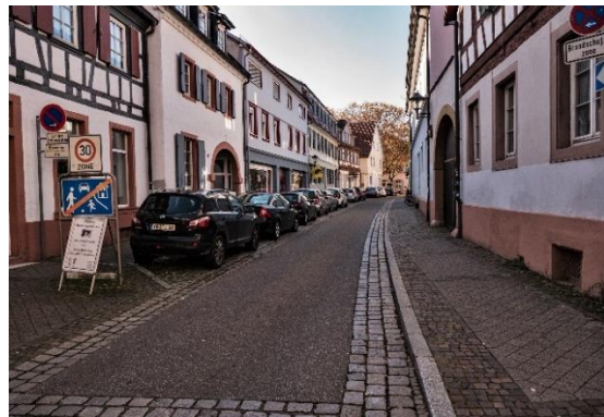
Abbildung 26: Entwässerungsrinne aus Kopfsteinpflaster
