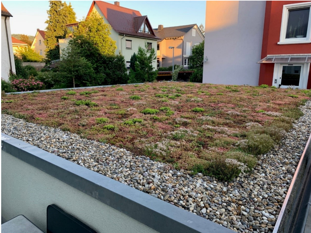
Geförderte Garagendachbegrünung ein Jahr nach der Fertigstellung
