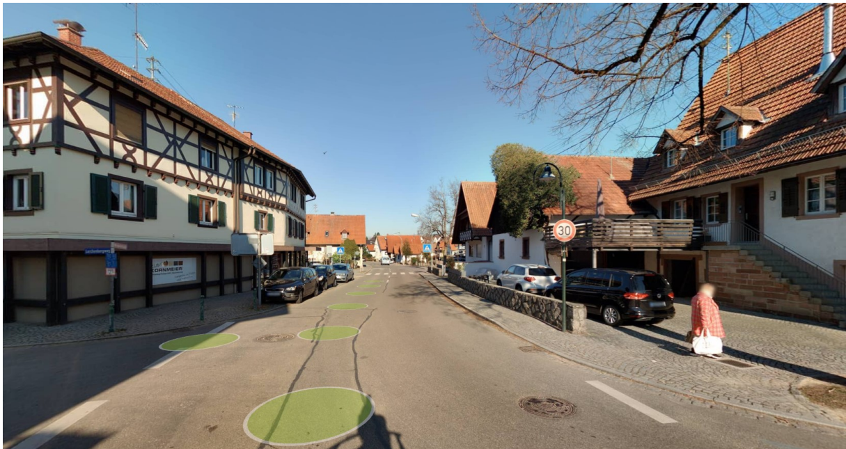
Abbildung 1: Zustand der Weingartenstraße
