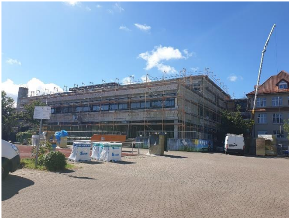
Umbau und energetische Sanierung Schillergymnasium
