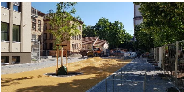
Umbau und Sanierung Georg-Monsch-Schule
