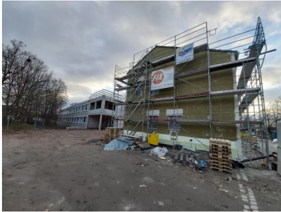
Ansicht Nordostseite - Rohbauarbeiten
