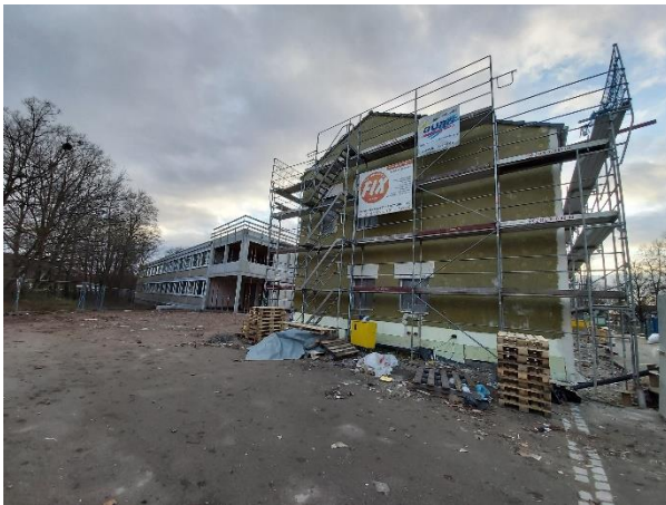
Umbau und Sanierung Eichendorff-Schule
