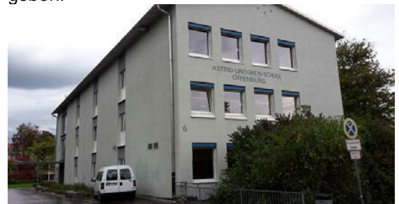
Nördliches Hauptgebäude Bestand
