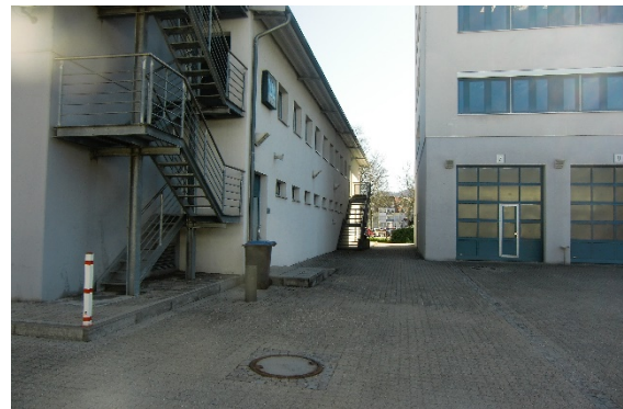
Gebäude Atemschutzwerkstatt (links)- Bestand
