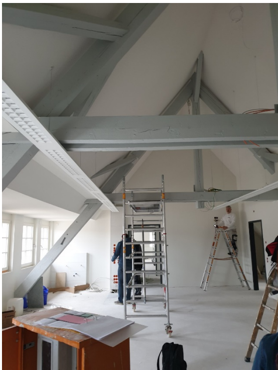
Ausbau Klassenräume in ehem. Hausmeisterwohnung
