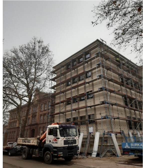
Ansicht Westen - Fassadenarbeiten
