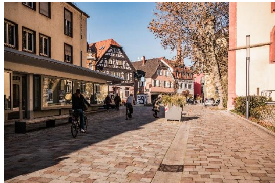
Quelle: Planersocietät, Weingartenstraße, Lange Straße
