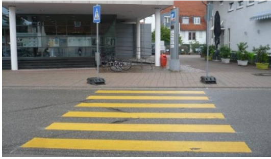
Abbildung 138: Beispiel für provisorischen Fußgängerüberweg an Baustelle
