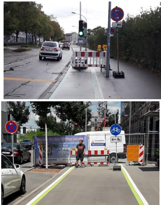
Abbildung 137: Beispiele für Baustellen in Offenburg
