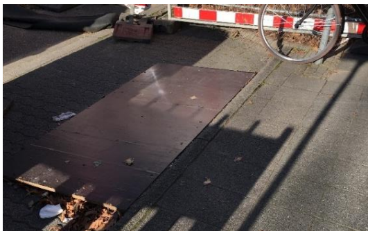
Abbildung 139: Beispiel für Bordsteinabsenkungen an Baustellen
