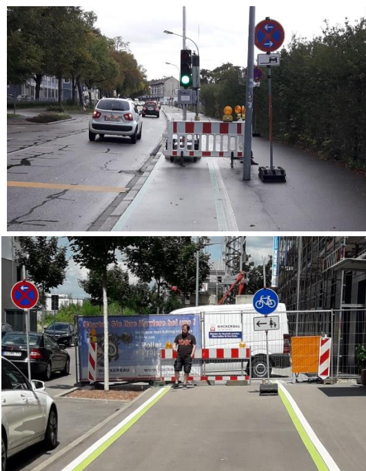
Abbildung 137: Beispiele für Baustellen in Offenburg
