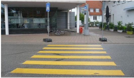
Abbildung 138: Beispiel für provisorischen Fußgängerüberweg an Baustelle
