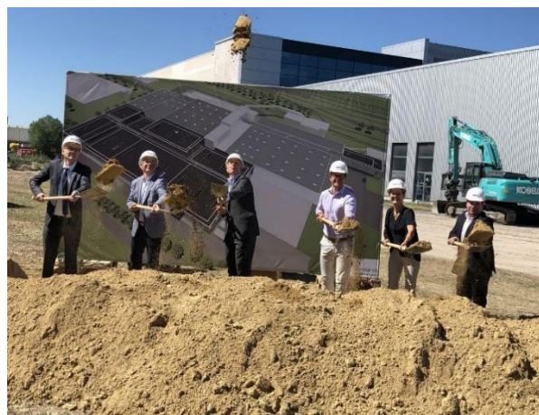
Spatenstich Erweiterung Burda-Druckzentrum (Foto: Christina Großheim)
