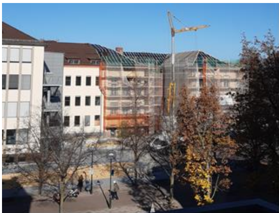
Ansicht Osten – Fassadenarbeiten 2. BA
