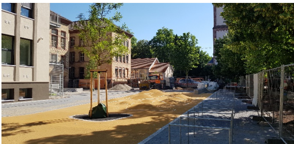
Umbau und Sanierung Georg-Monsch-Schule
