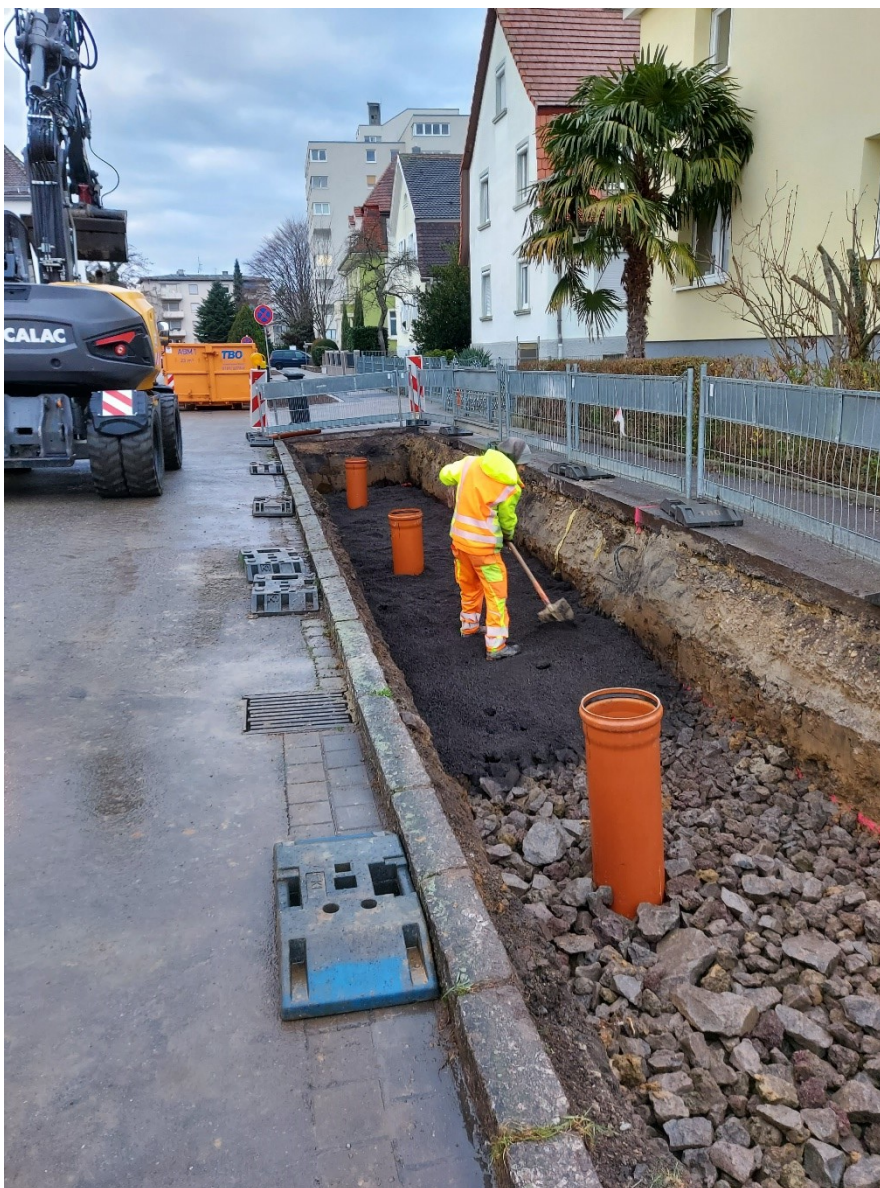
Abbildung 17: Die Herstellung der Baumquartiere in der Humboldtstraße
