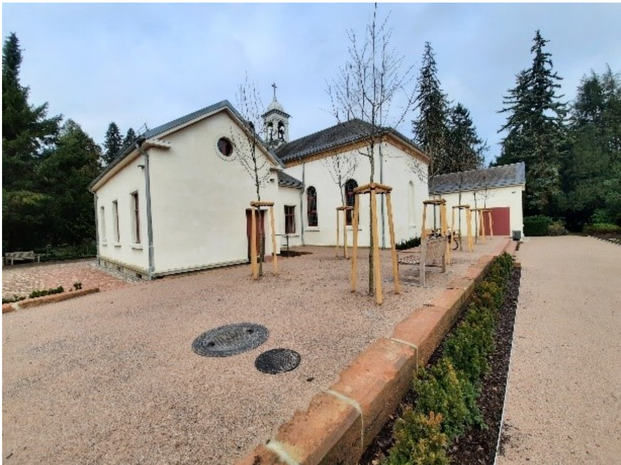
Standort des ehemaligen Wärterhauses nach Fertigstellung der Außenanlagen
