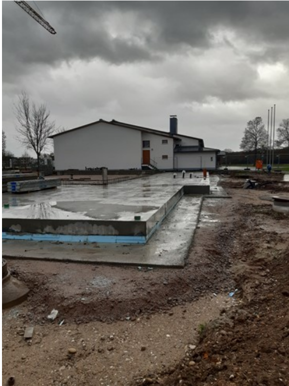
Stahlbetonbodenplatte
