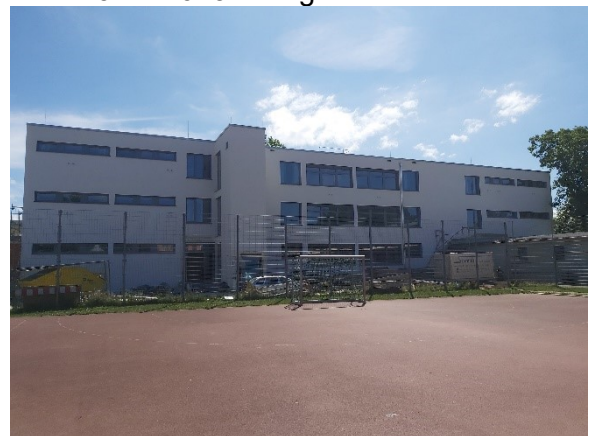
Ansicht Bauteil D – Westfassade mit Aufzugschacht
