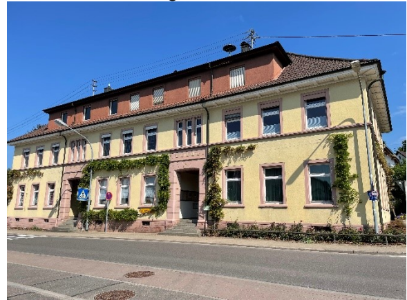
Bestandsgebäude Rathaus Rammersweier
