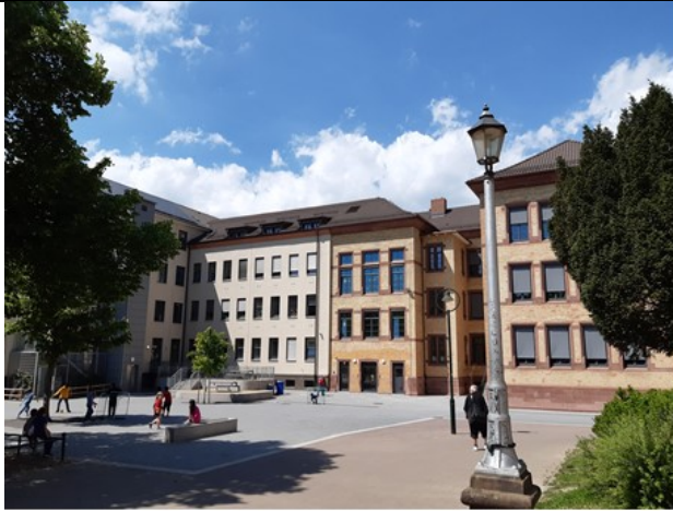
Fertigstellung Übergang BA 1 - BA 2, Aussenanlage
