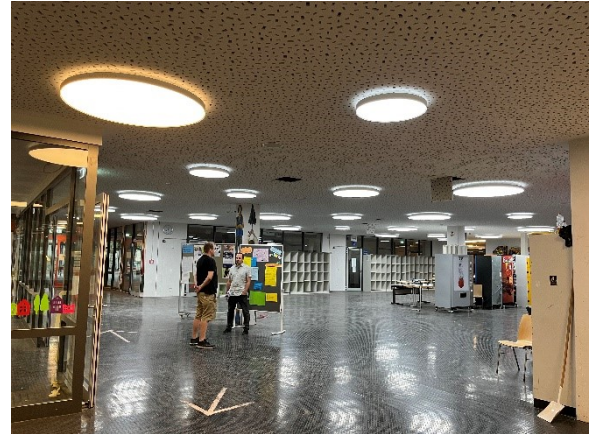
Aula nach Deckensanierung
