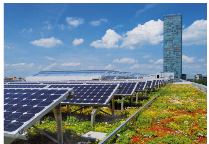
Abb. 55: Kombination aus Dachbegrünung und PV-Anlage, Nürtingen [DQ3]
