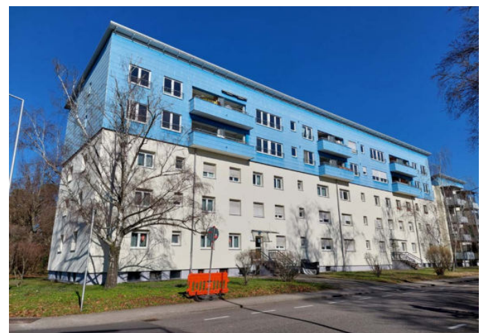
Abb. 59: Helle Fassadengestaltung bei Aufstockung, Karlsruhe [1]
