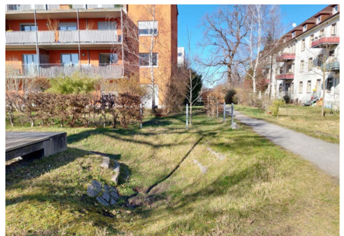
Abb. 44: Versickerungsmulde auf einer Grünfläche, Karlsruhe [1]
