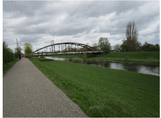
Bahnbrücke über die Kinzig
