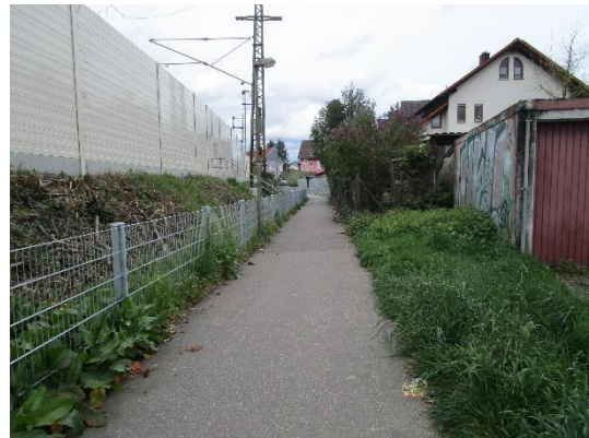
Fuß-/Radweg an Bahnlinie
