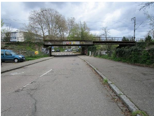
Bahn-Überführung Badstraße nach Norden
