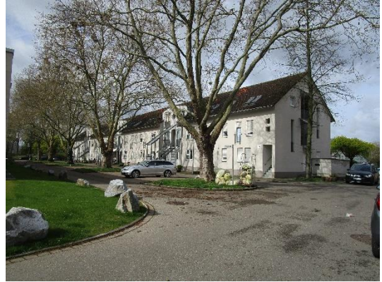
Fehlende Barrierefreiheit Eingangsbereiche
