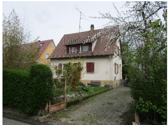
Sanierungsrückstau, insbesondere im energetischen Bereich
