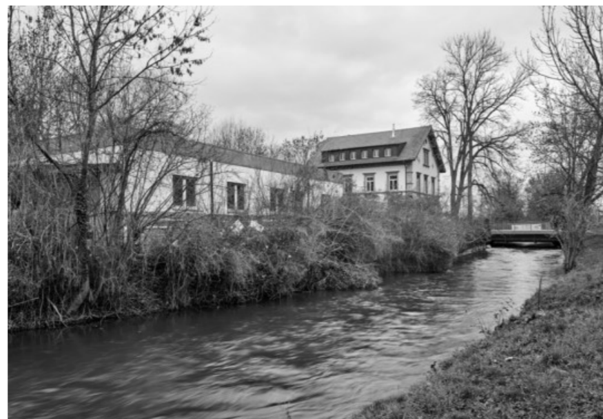
Der Blick auf die Räderbachinsel mit dem Stadtteil- und Familienzentrum Stegermatt heute. Foto: Michael Bode
