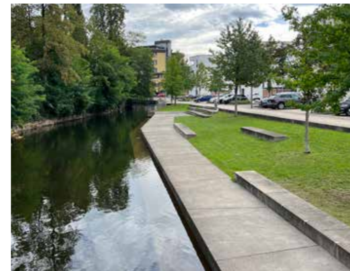
Neugestaltung Mühlkanalufer an der Alten Spinnerei
