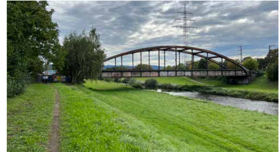
Kinzig Blick auf Eisenbahnbrücke nach Süden
