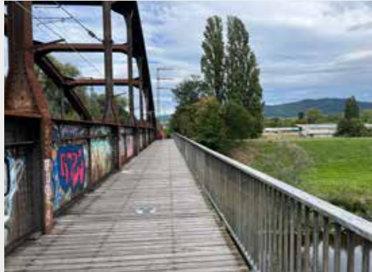
Radwegebrücke an der Bahn
