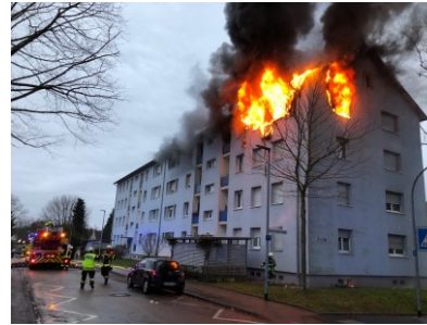
04.01.2023: Gebäudebrand, A.- Schweitzer-Str 3a, OG-Nordost
